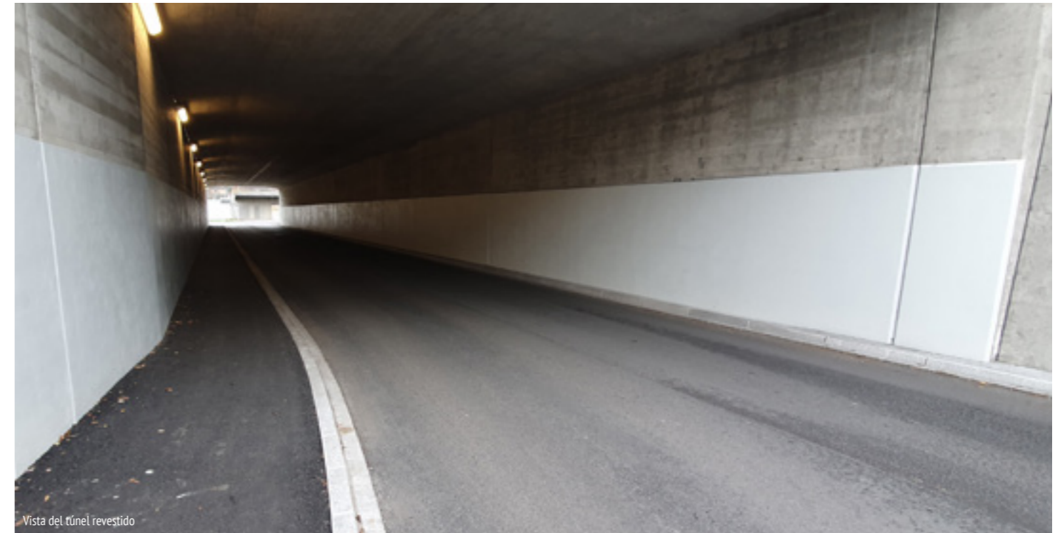
Vista del túnel revestido
