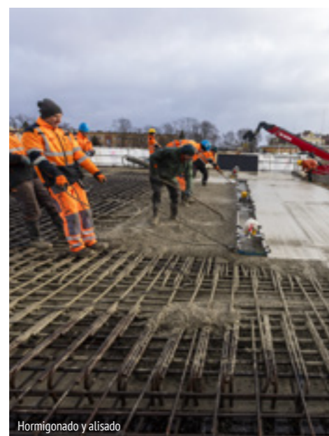
Hormigonado y alisado
