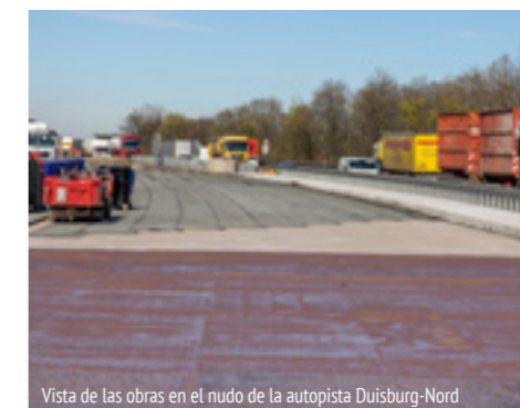
Vista de las obras en el nudo de la autopista Duisburg-Nord
