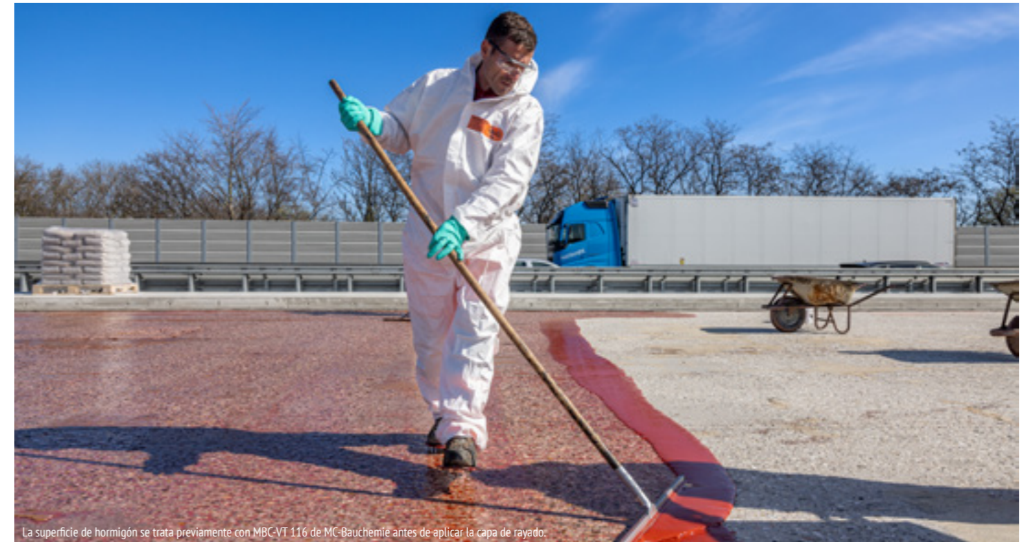
La superficie de hormigón se trata previamente con MBC-VT 116 de MC-Bauchemie antes de aplicar la capa de rayado.
